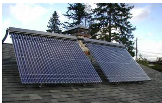
Рис. 2. Вакууммированные стеклянные трубчатые КСЭ
